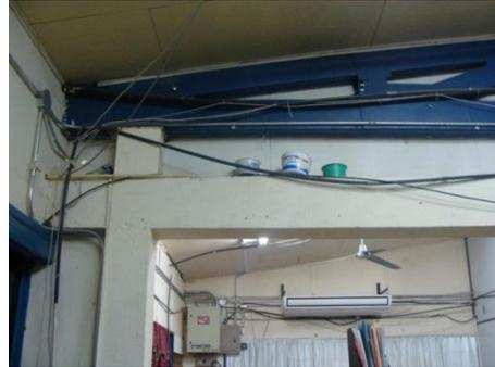
Instalaciones de la DGME en el puesto fronterizo de Paso Canoas. La infraestructura tiene problemas de filtraciones de agua cada vez que llueve (goteras), la instalación eléctrica está expuesta, así como los equipos de cómputo. Cuando llueve fuerte se inunda el área, y la solución temporal es colocar recipientes. (Imágenes captadas en la primera semana de septiembre 2014).
