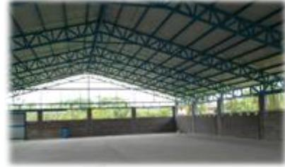
La obra ejecutada corresponde a una edificación con piso de cemento, paredes de bloques de concreto y malla metálica, no cuenta con un sistema de iluminación acorde con sus dimensiones, las líneas de suministro de energía eléctrica no reúnen condiciones mínimas de seguridad, las áreas de servicios sanitarios y cocina no han sido acondicionadas, lo que dificulta el uso del salón. Las fotografías ilustran lo señalado.
